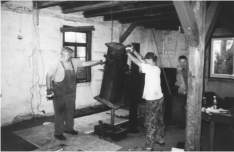
Nur mit speziellen Hebwerkzeugen konnten die zum Teil eine halbe Tonne schweren Einzelteile der Ballotpresse abgebaut werden. Links: Georg Schalk vom Bauhof Wolnzach, der die Abbauleitung übernahm.
